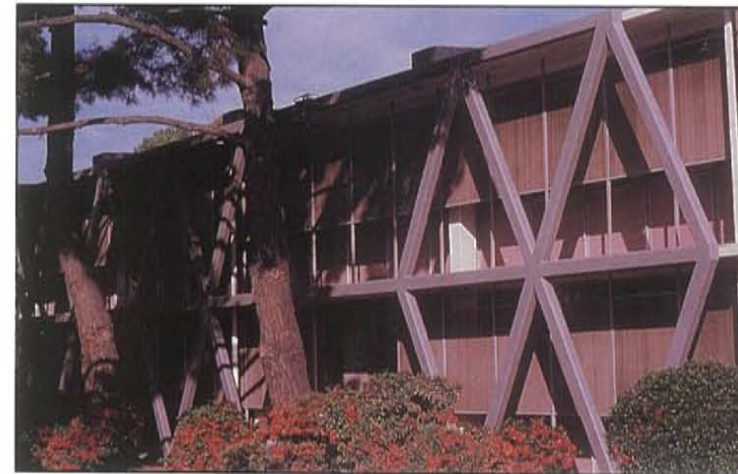
Un marco diagonal de acero refuerza efectivamente el marco de concreto de un edificio del U.S. Geological Survey.
