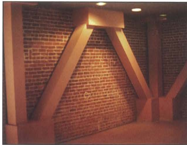
Los edificios de ladrillo pueden ser reforzados atornillando paredes exteriores a marcos internos reforzados.
