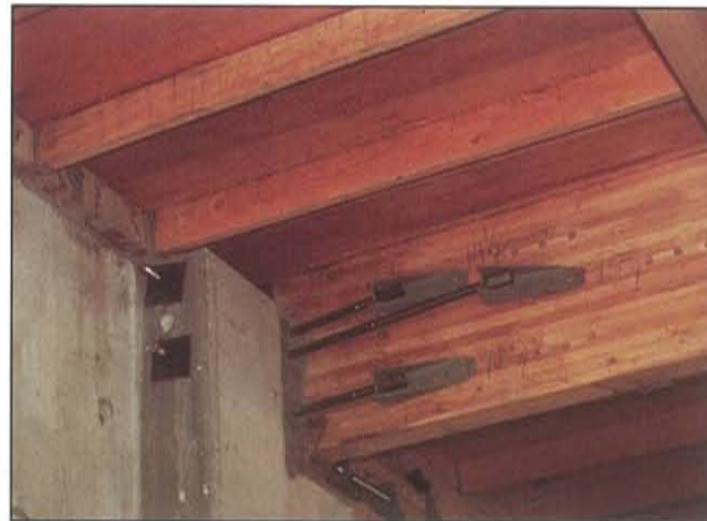
可以多加些結來堅固較老的建築物。
