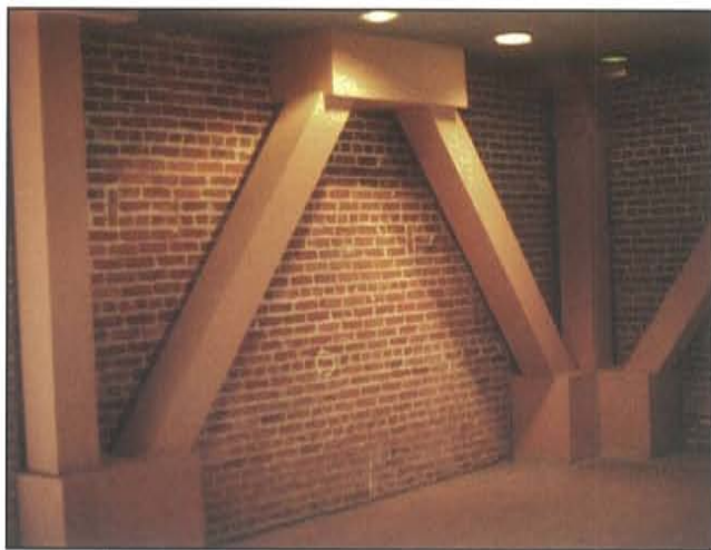
此圖顯出如果要使磚造建築物比較可以抵抗地震的話，是要強固外牆在內框上。
